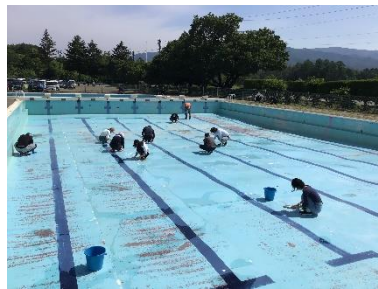
プールの穴埋め
