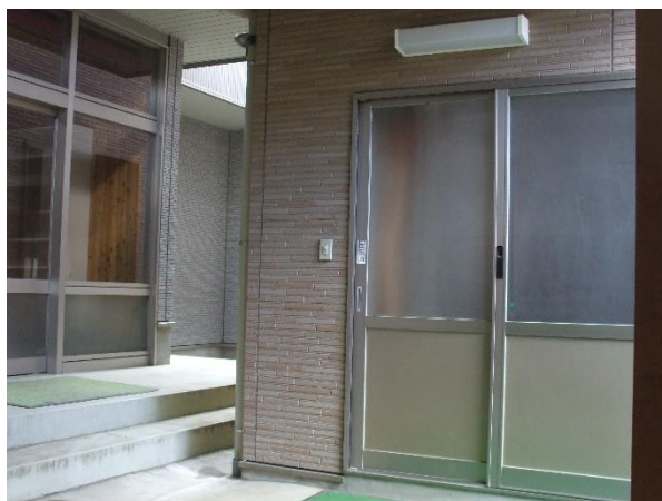
入口（キーボックスを設置）
